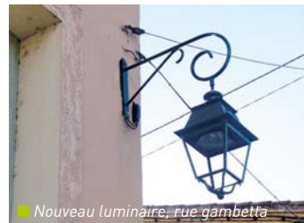
Nouveau luminaire, rue gambetta
