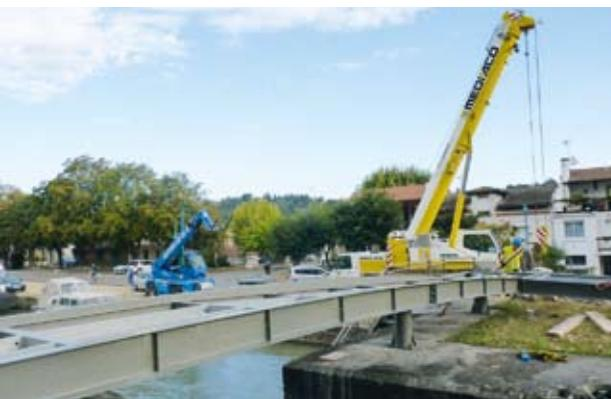
Respectant les normes d'accessibilité, la passerelle est équipée d'un léger plan incliné afin d'être accessible aux personnes à mobilité réduite. A l'avenir, des garde-corps, équipés d'un éclairage à LED pour la nuit, compléteront la structure métallique. Un aménagement paysager séparera la zone des plaisanciers de la voie réservée aux cycles et piétons.
