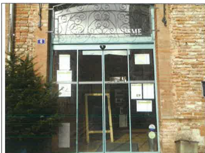
Façade Office de Tourisme
