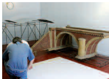
Installation des structures métalliques réalisées par les ateliers municipaux
