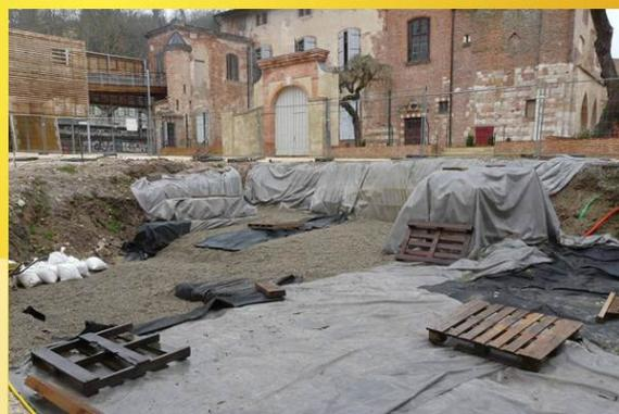
Ce sont les réalisations qui ont dû être faites pour la protection immédiate des vestiges : le carrelage est protégé par un géotextile recouvert par du gravier de façon à bien maintenir et drainer cette protection en géotextile, et au-dessus desquels il y aura 50 cm de terre végétale pour créer ce jardin archéologique.
