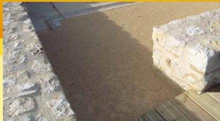
Protection des sols et banquettes par géotextile, lit de sable et 50cm de terre
