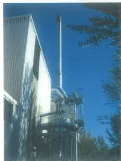
Incinérateur de Montauban
