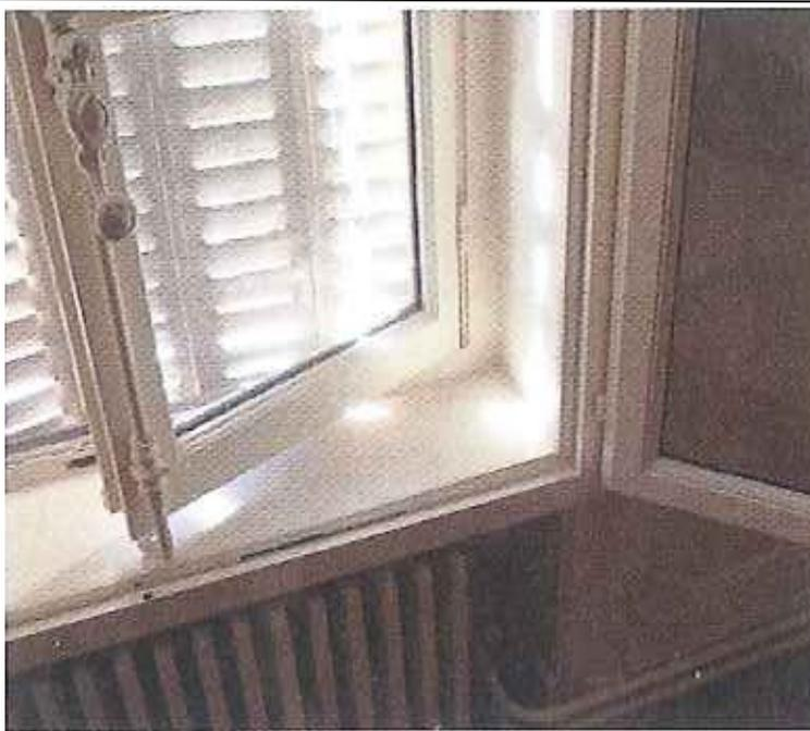
Doubles fenêtres en réhabilitation. la seconde fenêtre (neuve) s'ouvre contre le nu intérieur mur alors que l'ancienne s'ouvre dans l'ébrasement. avec une lame d'air. Ces doubles fenêtres peuvent être ouvrantes ou coulissantes et par exemple intégrées dans un dispositif d'isolation intérieure. Un double vitrage de rénovation ou un survitrage intérieur non visible de l'extérieur pourra être installé sur la menuiserie ancienne.
