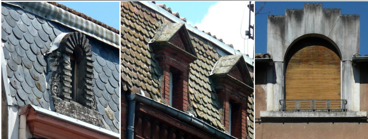
De gauche à droite : Lucarnes sur brisis de toits mansardés. Couverture en ardoise ou en tuile plates en écailles de poisson . Lucarne passante années 1930, rue Cayrou.
