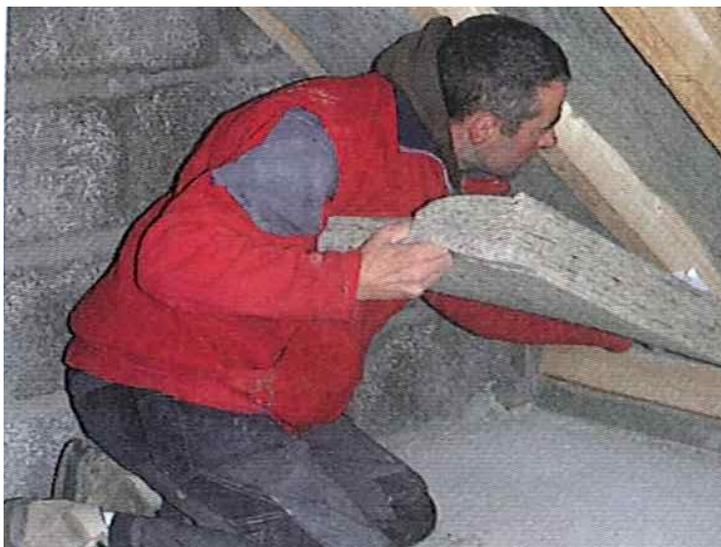
Principe de l'isolation des combles praticables. Pose d'isolant entre chevrons sous la couverture. Source : L'isolation thermique écologique, Oliva et Cougey, 2010.
