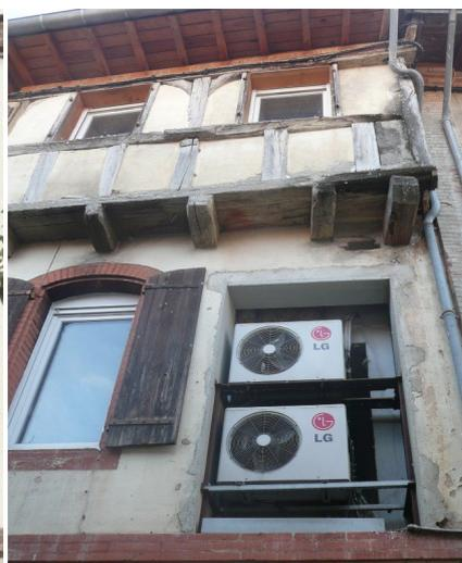
Appareil de climatisation en façade. Fenêtre non adaptée à la forme de l'encadrement, absence de partition de la baie.
