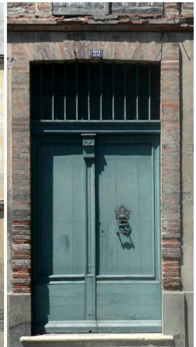
Détails d'une architecture soignée sur le grand boulevard d'entrée de ville. Au centre encadrement de porte en briques enduites et badigeonnées à l'imitation de la pierre de taille.
