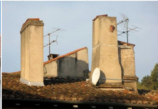
Exemples de mitres de cheminées en tuiles canal, d'enduits et de protections de solins sur bâtis anciens. Mitres en tuiles mécaniques sur bâti des années 1930.
