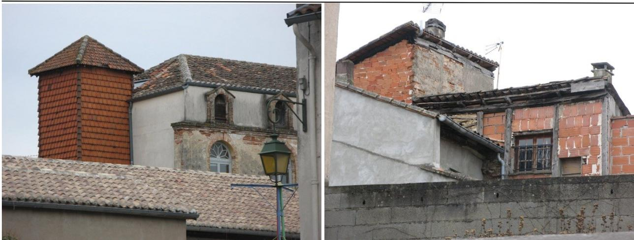
Utilisation de matériaux inadéquats dans les restaurations du bâti ancien. Tour couverte de tuiles mécaniques. Pans de bois hourdés de parpaings sans enduits.
