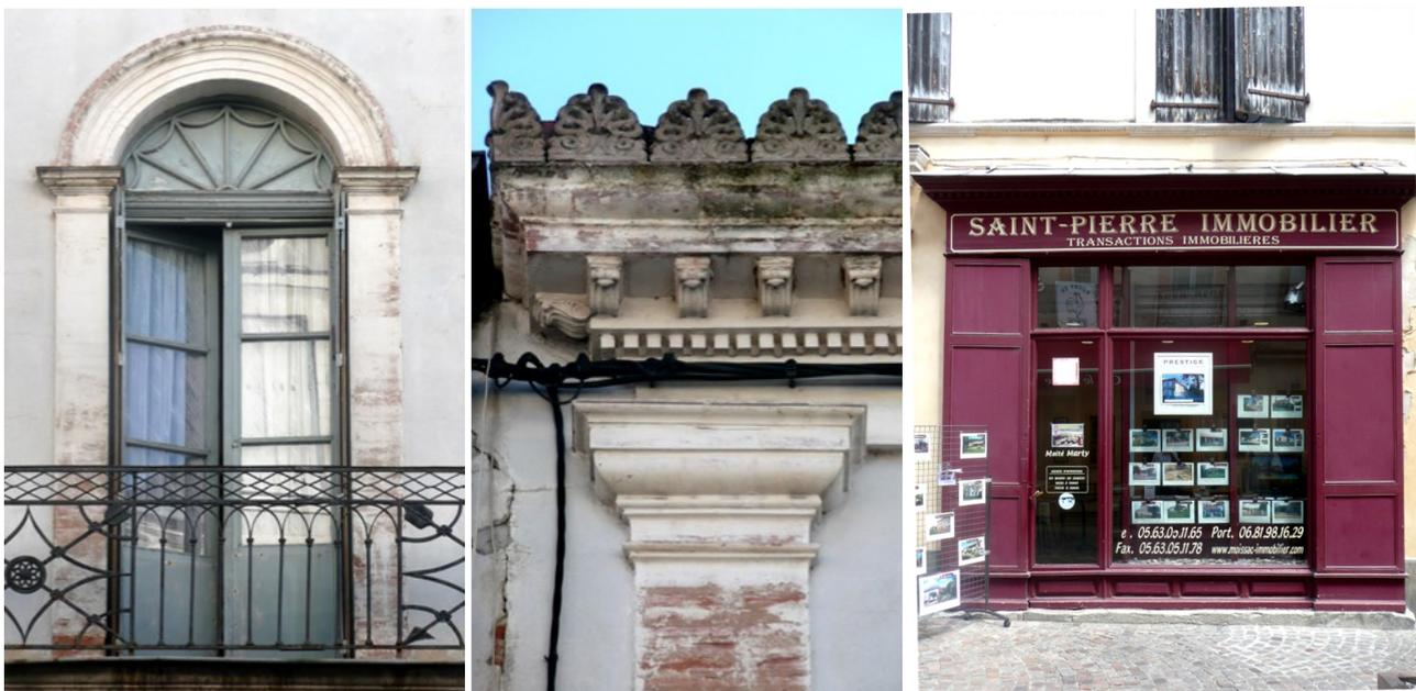
Détails d'architectures des XVIII<sup>e</sup> et XIX<sup>e</sup> siècles: balcons ouvragés, détails de baies et décors architecturés des façades, corniches et pilastres en briques enduites et badigeonnées à l'imitation de la pierre, devantures menuiseries des boutiques.
