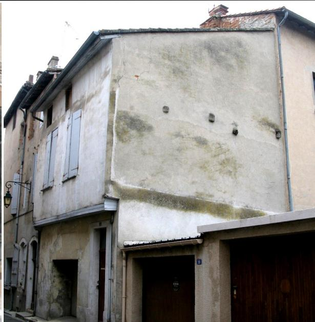
*Effets d'un enduit imperméable sur une maçonnerie traditionnelle. Les traces d'humidité provoquées par les remontées capillaires sont visibles sur toute la façade. Lorsque l'humidité ne peut s'évacuer au travers d'un enduit perméable, sous l'effet de la pression l'eau peut remonter sur plusieurs étages. Les maçonneries gorgées d'eau sont en péril, l'atmosphère de la maison est humide et inconfortable.*
