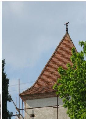
Les matériaux de couverture sont choisis en fonction du type de l'édifice, du type de toiture et la pente du toit. Couverture d'un rampant de comble à surcroît (XX<sup>e</sup> siècle) en ardoise. Tuiles mécaniques sur certains bâtis des années 1930 (Détail des arêtières et épis de faîtages en terre cuite). La tuile plate est adaptée à certains ouvrages dont la pente est prononcée.
