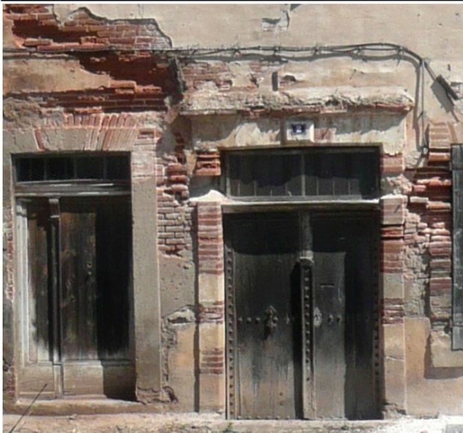
*Effets désastreux du point de marnage dans la brique. Les sels contenus dans les remontées capillaires rongent la brique. La pose d'un enduit non perméable et non perspirant (ciment, résines..) ayant pour effet d'emprisonner l'eau dans les maçonneries aggrave la situation.*
