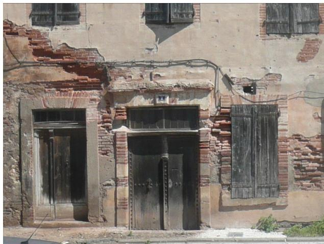
Remontées capillaires et désagrégation des maçonneries anciennes.
