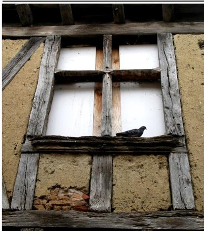
Croisée en bois sur maçonnerie en pans de bois ; XV<sup>e</sup> et XVI<sup>e</sup> siècle. Croisillon à meneau et traverse. La croisée peut également être en pierre sur les murs maçonnés en briques.
