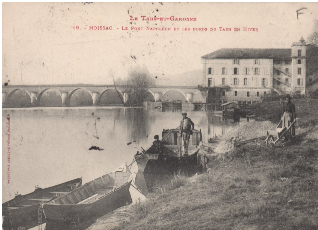
Le pont, la berge et le moulin avant le grand incendie de 1910 . 2 Fi Moissac 126. A.D.T.G.
