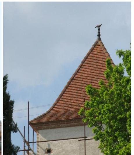
Les matériaux de couverture sont choisis en fonction du type de l'édifice, du type de toiture et la pente du toit (1-19-5.c) Couverture d'un rampant de comble à surcroît (XX e siècle) en ardoise. Tuiles mécaniques sur certains bâtis des années 1930 Détail des arêtiers et épis de façtages en terre cuite. La tuile plate est adaptée à certains ouvrages dont la pente est prononcée (pigeonniers par exemple.)
