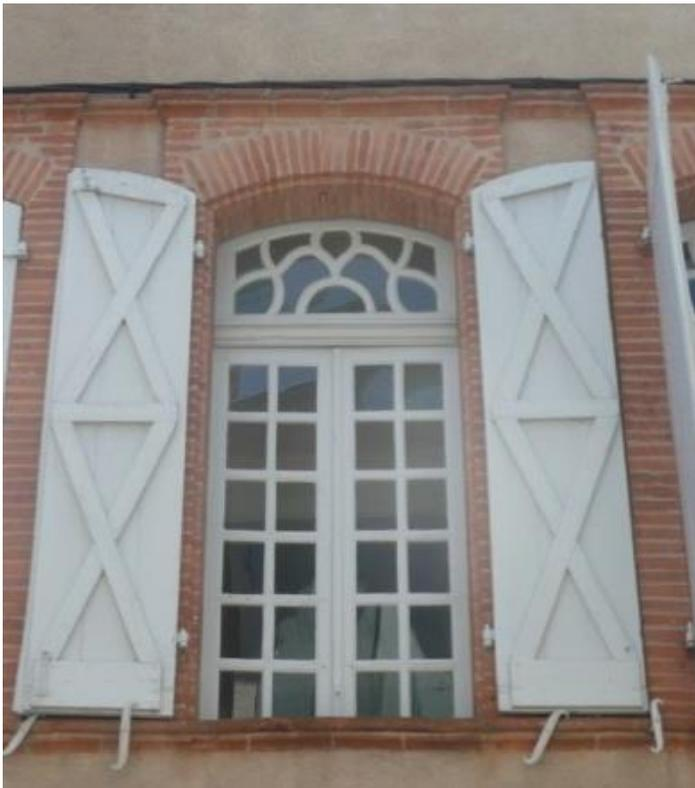
*Le calfeutrement des menuiseries et le maintien des contrevents permettent de protéger du froid et du vent en hiver et des excès du rayonnement solaire estival (1-21-6.c).*
