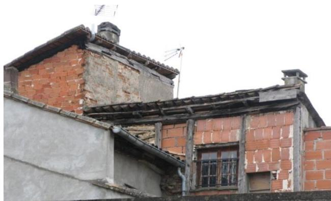
Exemple de restauration de pans de bois à proscrire (1-6-7.c) : remplissage du pan de bois avec des matériaux non adaptés et masquage des pans de bois avec un enduit ciment.
