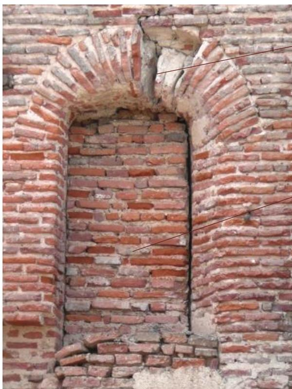
*Les briques dégradées ou manquantes sont à restituer avec des matériaux conformes aux dispositions originelles*
