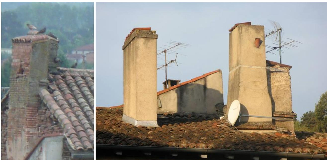
*Exemples de mitres de cheminées en tuiles canal, d'enduits de protections de solin maçonnés à avec des tuiles canal et de la chaux grasse (1-18-6.c.)*
