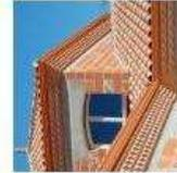
harmonie de tons des enduits joint en creux soulignant un détail, poteaux fins et sablières métalliques, dalles et toitures en zinc, l'ensemble mieux réglé et finis.
