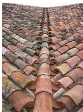
Détail de bouconnage et tuile baveuse de récupération Noüe à gruissiers
