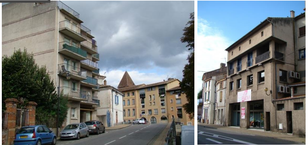
Edifices en rupture : non-respect des trames bâties (parcellaires), des gabarits, des typologies de composition et des matériaux.
