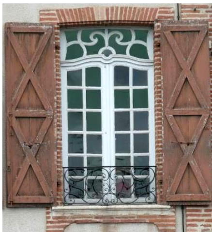
Menuiseries d'époque moderne (XVIII e ) à conserver ou restaurer en respectant la forme de la baie, le modèle et les matériaux d'origine (1-10-7.c)
