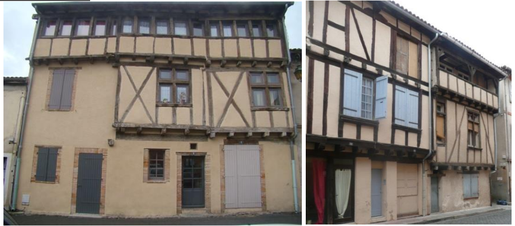
Maisons à pans de bois et briques enduites. Encorbellement des étages, et mirandes.
