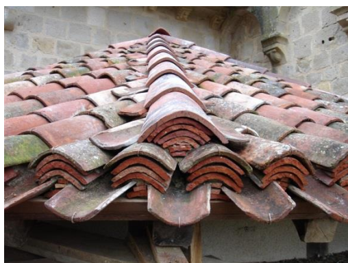
Détail de bouconnage et tuile baveuse de récupération Noüe à gruissiers
