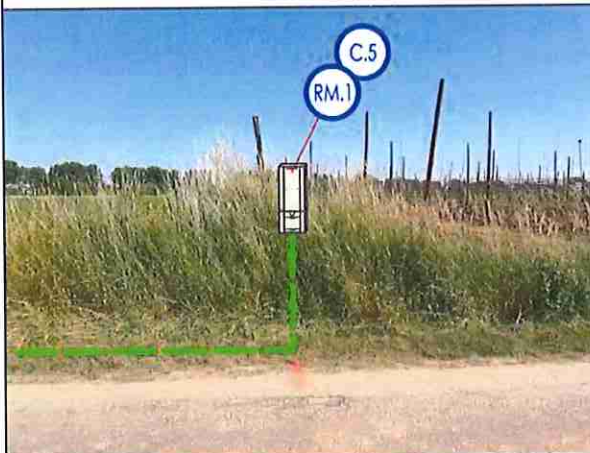
RM.1: Pose 1 Coffret Réseau + Pose 1 Coffret comptage C5 TRI
