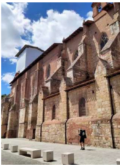
Restauration de la toiture du clocher de l'abbatiale, 2022.
