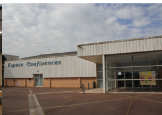
Façade de la salle avec le hall d'entrée.
