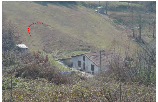
Lieu dit « Catiès » Glissement supposé
